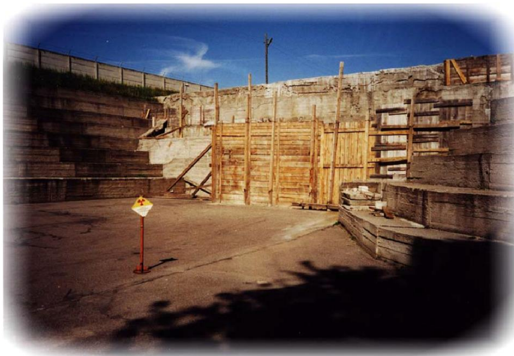
Rys. 9.8 Fragment fosy w Krajowym Składowisku Odpadów Promieniotwórczych w Różanie. Część fosy jest już wypełniona i zamknięta pionową ścianą betonową.
