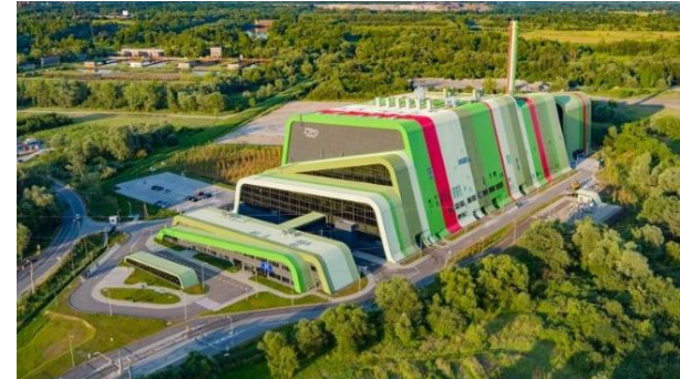
Rys. 6. Zakład Termicznego Przekształcania Odpadów Komunalnych w Krakowie [8]
