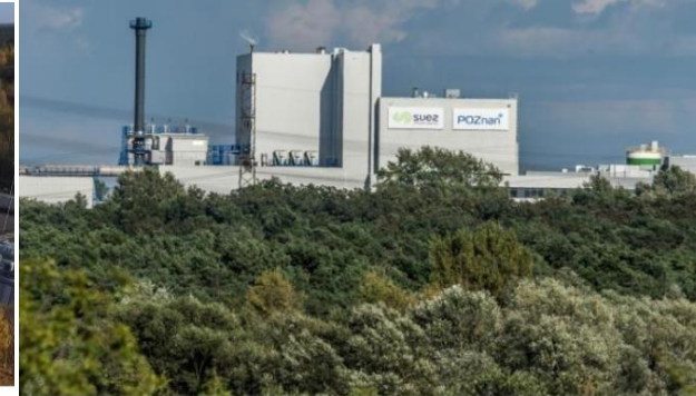
Rys. 9. Instalacja Termicznego Przekształcania Odpadów Komunalnych w Poznaniu [15]
