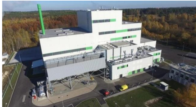
Rys. 8. Zakład Unieszkodliwiania Odpadów Komunalnych w Białymstoku [14]
